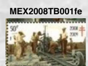
CAMBIO DE DURMIENTES
