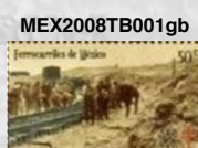
TENDIDO DE VÍA (2/2)
