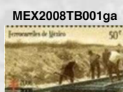
TENDIDO DE VÍA (1/2)
